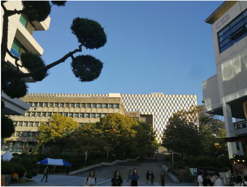
Bibliothek (Alt- & Neubau)
